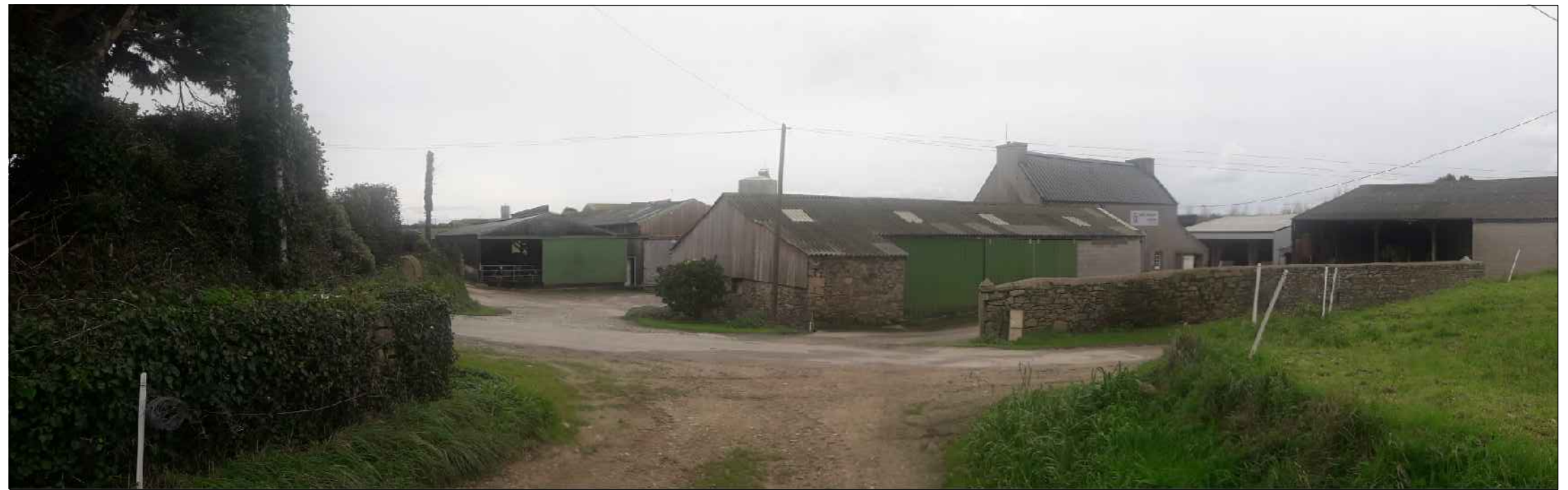
PRISE DE VUE DE LA PHOTO A
